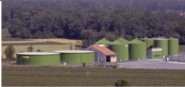
Ökostrom Mureck GmbH Start Data 20/03/06, Finish data 30/09/07
