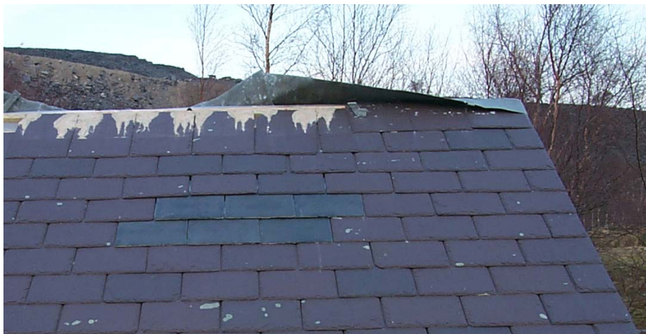
Fig.AK. McAlpine Test Roof.
