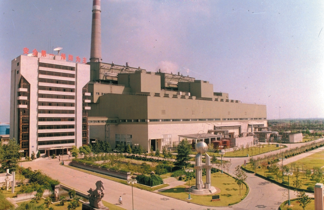
Yue Yang 350MWe Downset-Fired Unit in China
